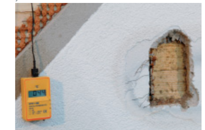
Después de 15 minutos, temperatura superficie: 1080° Temperatura de la superficie sobre madera: 44°C, No se causó daño a la construcción de madera
