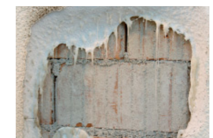
Estado de aislamiento Styrofoam después del enfriamiento
