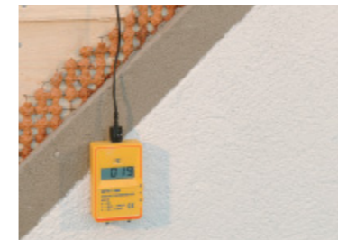
Construcción de madera cubierta con parrilla Metálica, Mortero THERMOSILIT® de cal/yeso, Temperatura inicial: 19°C
