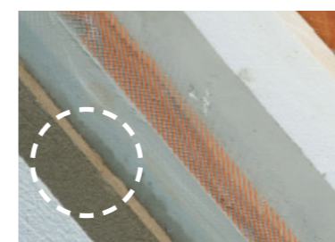
Construcción de madera cubierto con Styrofoam Aislamiento cubierto con Mortero THERMOSILIT® cal/yeso, Temperatura inicial: 19°C
